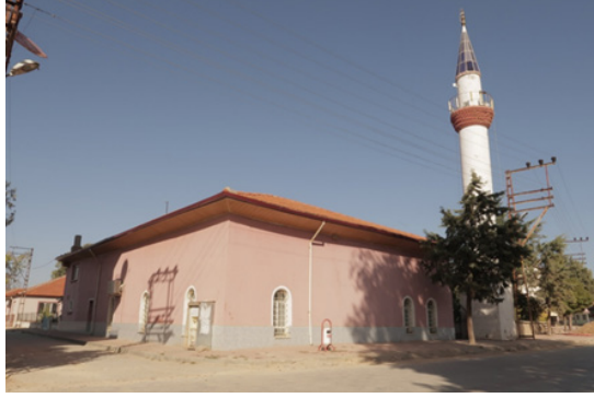
Şekil 1: Afyonkarahisar Başmakçı Recep Bey Camii, güney batı cephesi
